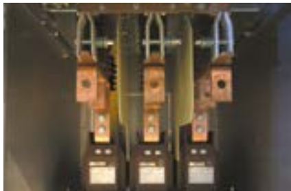
Рис. 1.3 Линейный отсек
