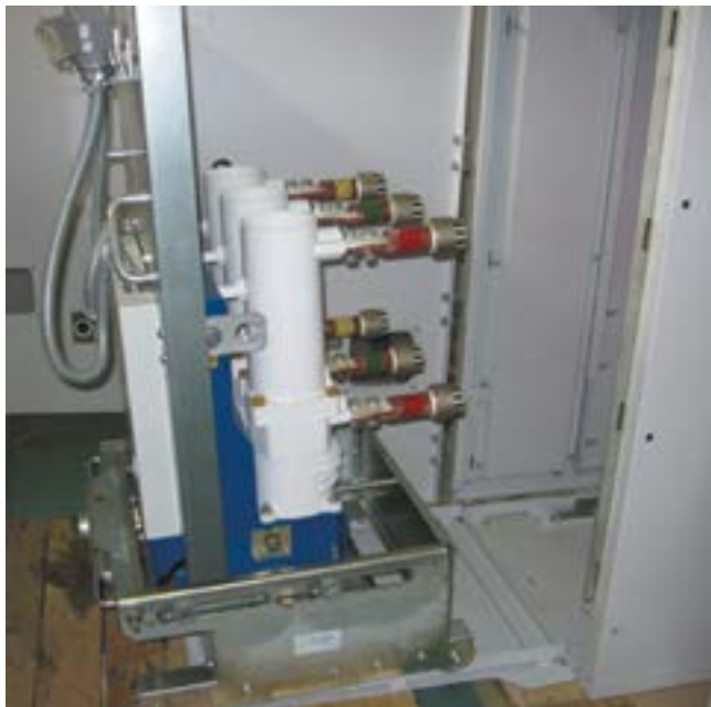
Рис. 3.14 Выкатной элемент а) выкатной элемент в ремонтном; б) ламель заземления ВЭ (вид снизу); в) выдвижной элемент (траверса) в контрольном положении (вид снизу). 1 – палец-привод шторочного механизма; 2 – механизм фиксации и доводки выдвижного элемента (траверса); 3 – розеточные контакты; 4 – выдвижной элемент с выключателем; 5 – основание выкатного элемента; 6 – замок электромагнитный ЭМБЗ; 7 – рукоятки фиксатора; 8 – шток; 9 – фиксатор; 10 – штепсельные разъемы; 11 – выключатели концевые; 12 – рычаг выключателя концевого; 13 – тяга; 14 – основание выдвижного элемента; 15 – палец; 16 – винт; 17 – ламель заземления; 18 – фасадный лист ВЭ
