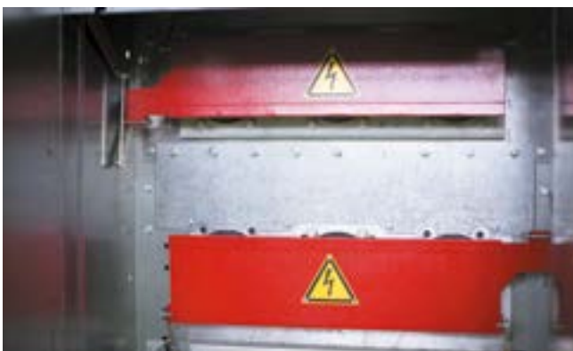
Рис. 2.12 Шторочный механизм
