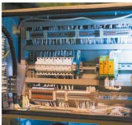
Рис. 1.15 Релейный отсек
