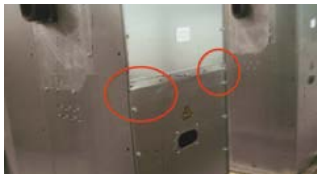
Рис. 2.9 Съемная панель для доступа в линейный отсек
