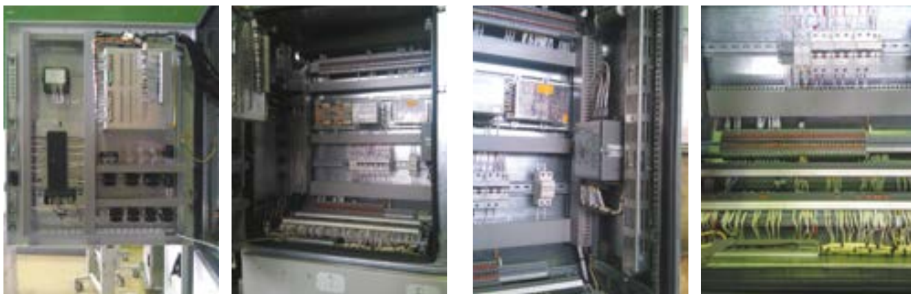
Рис. 3.16 Пример размещения аппаратуры в РШ
