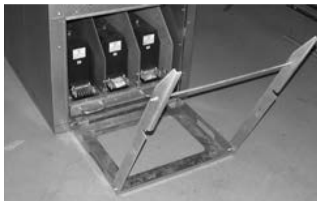
Рис. 1.7 Направляющие для ВЭ с ТН
