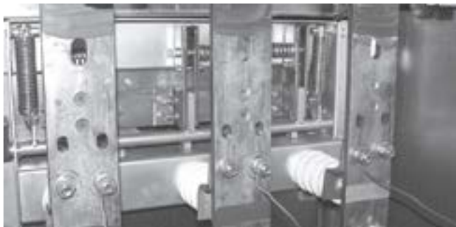
Рис. 2.13 Заземляющий разъединитель
