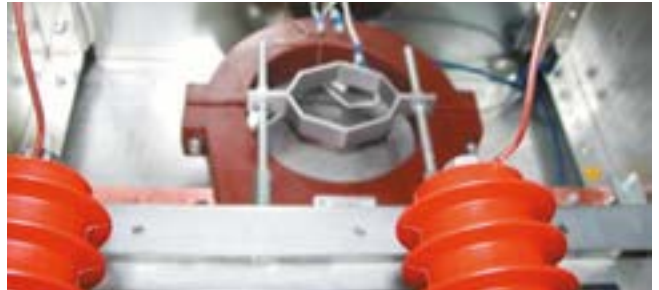
Рис. 2.11 Размещение разборных трансформаторов нулевой последовательности и алюминиевого хомута
