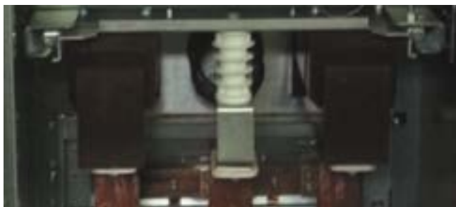
Рис. 2.10 Размещение проходных трансформаторов тока
