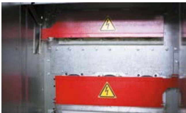
Рис. 2.12 Шторочный механизм
