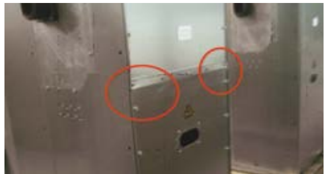
Рис. 2.9 Съемная панель для доступа в линейный отсек
