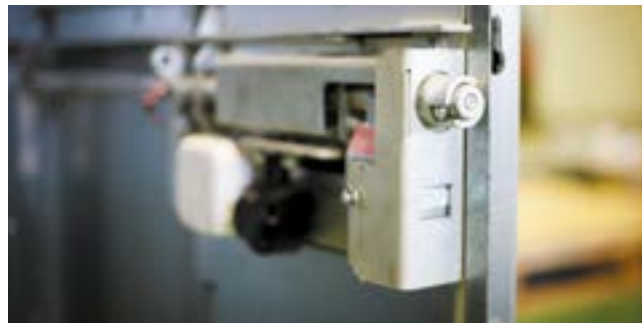
Рис. 2.14 Привод заземляющего разъединителя
