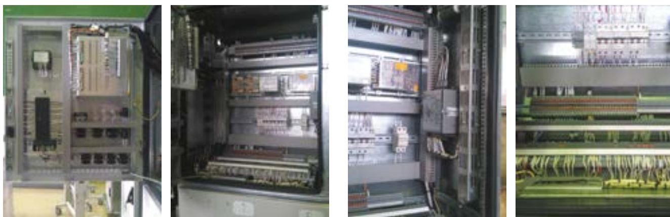
Рис. 3.16 Пример размещения аппаратуры в РШ
