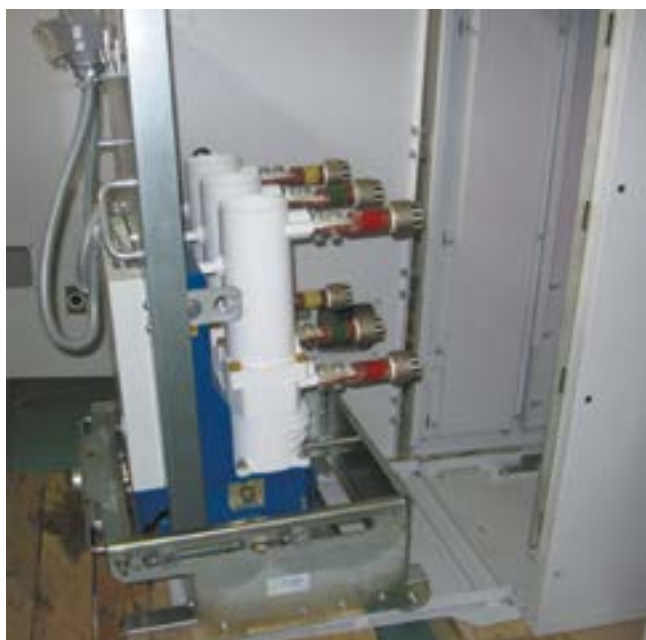
Рис. 3.14 Выкатной элемент а) выкатной элемент в ремонтном; б) ламель заземления ВЭ (вид снизу); в) выдвижной элемент (траверса) в рабочем положении (вид сверху). 1 – палец-привод шторочного механизма; 2 – механизм фиксации и доводки выдвижного элемента (траверса); 3 – розеточные контакты; 4 – выдвижной элемент с выключателем; 5 – основание выкатного элемента; 6 – замок электромагнитный ЭМБЗ; 7 – рукоятки фиксатора; 8 – шток; 9 – фиксатор; 10 – штепсельные разъемы; 11 – выключатели концевые; 12 – рычаг выключателя концевого; 13 – тяга; 14 – основание выдвижного элемента; 15 – палец; 16 – винт; 17 – ламель заземления; 18 – фасадный лист ВЭ
