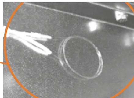
Рис. 2.34 Оптоволоконные датчики ДЗ Орион-ДЗ в отсеке сборных шин
