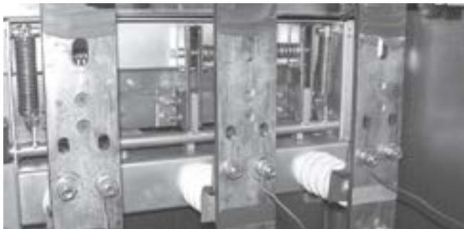
Рис. 2.13 Заземляющий разъединитель
