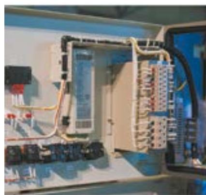
Рис. 1.15 Релейный отсек
