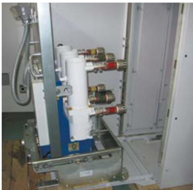
При вкатывании выкатного элемента по направляющим в отсек ВЭ, ламель заземления, установленная под его основанием входит в зацепление с неподвижным контактом установленным на основании отсека выкатного элемента. Электрическая связь ВЭ и РШ осуществляется штепсельным разъемом. ВЭ может занимать следующие фиксированные положения относительно корпуса шкафа: рабочее, контрольное, разобщенное и ремонтное:
