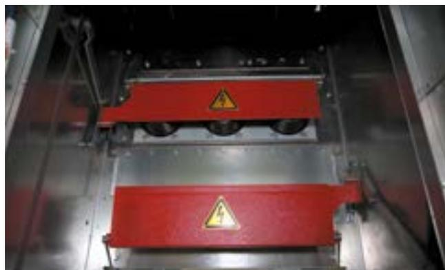
Заземляющий разъединитель стреляющего типа смонтирован в верхней части линейного отсека, над трансформаторами тока.
