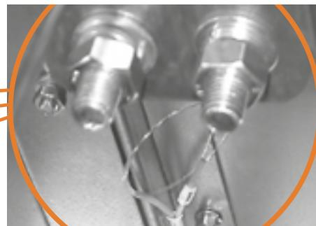
Рис. 2.33 Оптоволоконные датчики ДЗ Орион-ДЗ в линейном отсеке
