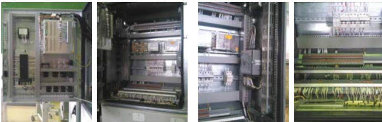
Рис. 3.16 Пример размещения аппаратуры в РШ
