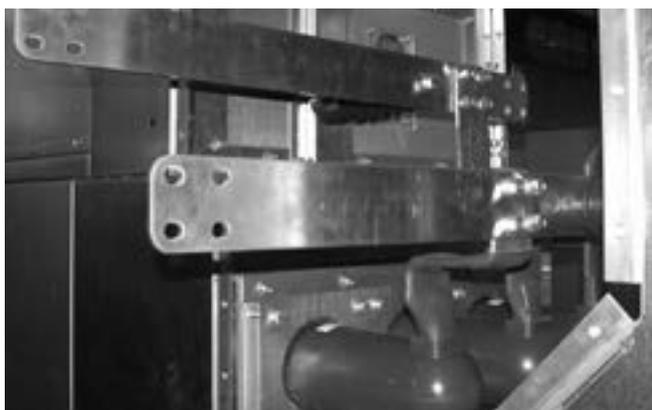
Рис. 1.6 Медные шины в отсеке сборных шин
