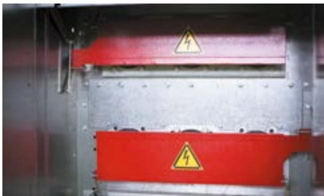
Рис. 2.12 Шторочный механизм
