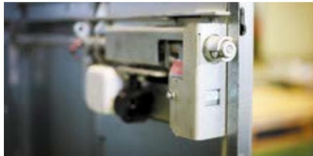
Рис. 2.14 Привод заземляющего разъединителя
