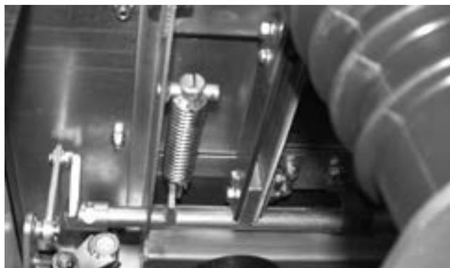
Заземляющий разъединитель шкафов (рис. 1.8) состоит из следующих составных частей: механизма заземления, подвижных контактов, неподвижных контактов, вала привода ЗР, флажка блокировки ЗР, привода заземлителя и индикатора положения ЗР. Заземляющий разъединитель (ЗР) смонтирован в линейном отсеке, под отсеком выкатного элемента.
